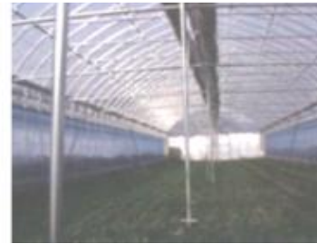
中柱（仮支柱）設置の写真
