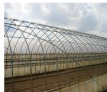
筋交いを入れた写真
