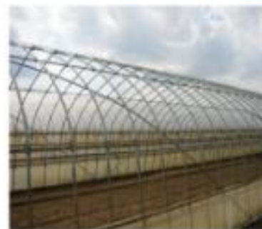
筋交い直管による補強
