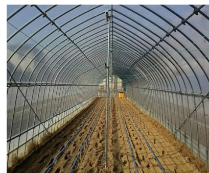
筋交い直管による補強
