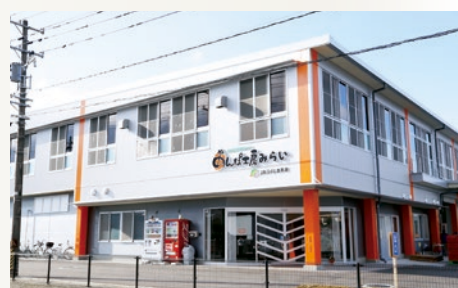
あんぽ工房みらい完成
